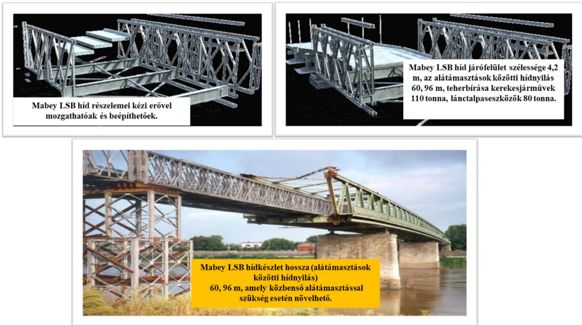
23. számú ábra. A Mabey LSB hídépítés közben, illetve a Mabey LSB hídkészlet alkalmazása 61 métert meghaladó hídnyílás esetén. 855
